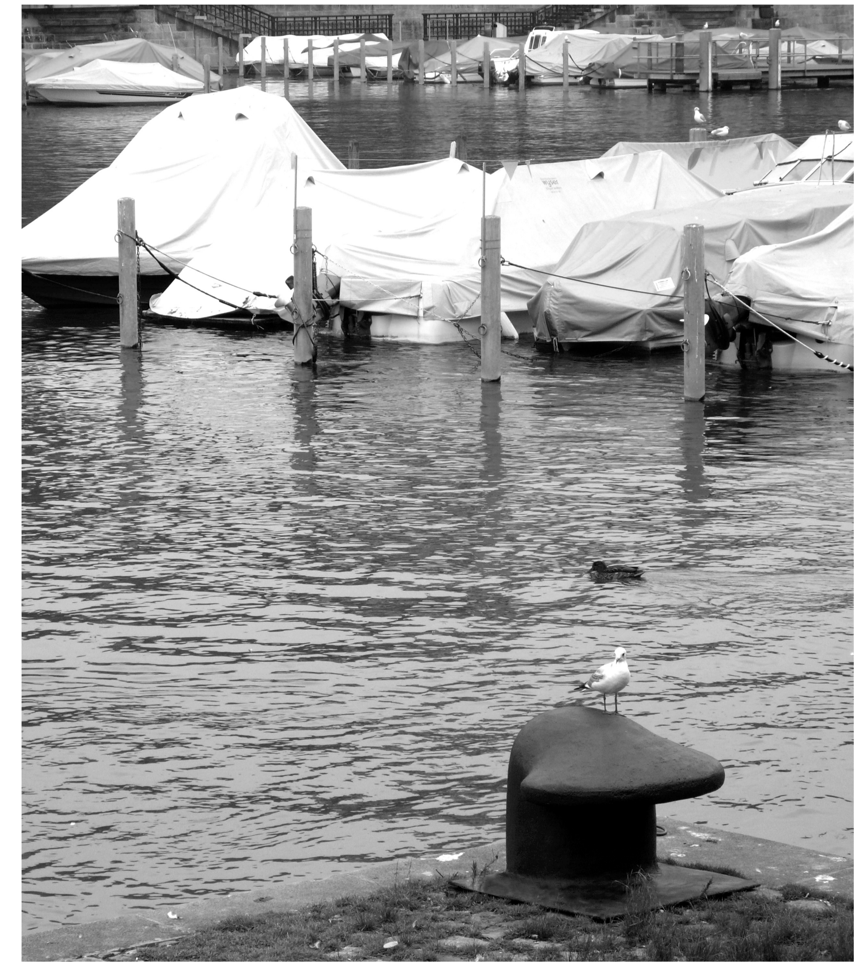
Der gusseiserne Hafenspiller misst 55 x 70 x 70 cm und wiegt rund 500 Kilo (Sphäroguss GG-50).
